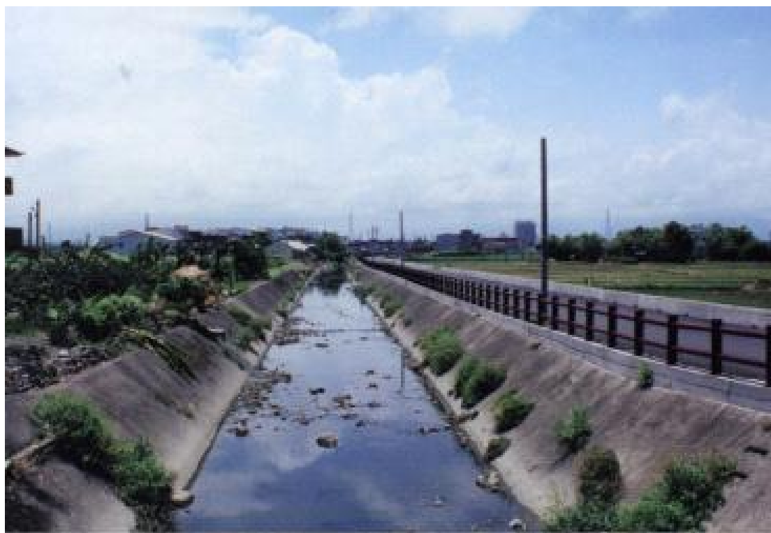
打那岸排水(南北四路橋向西拍攝)
