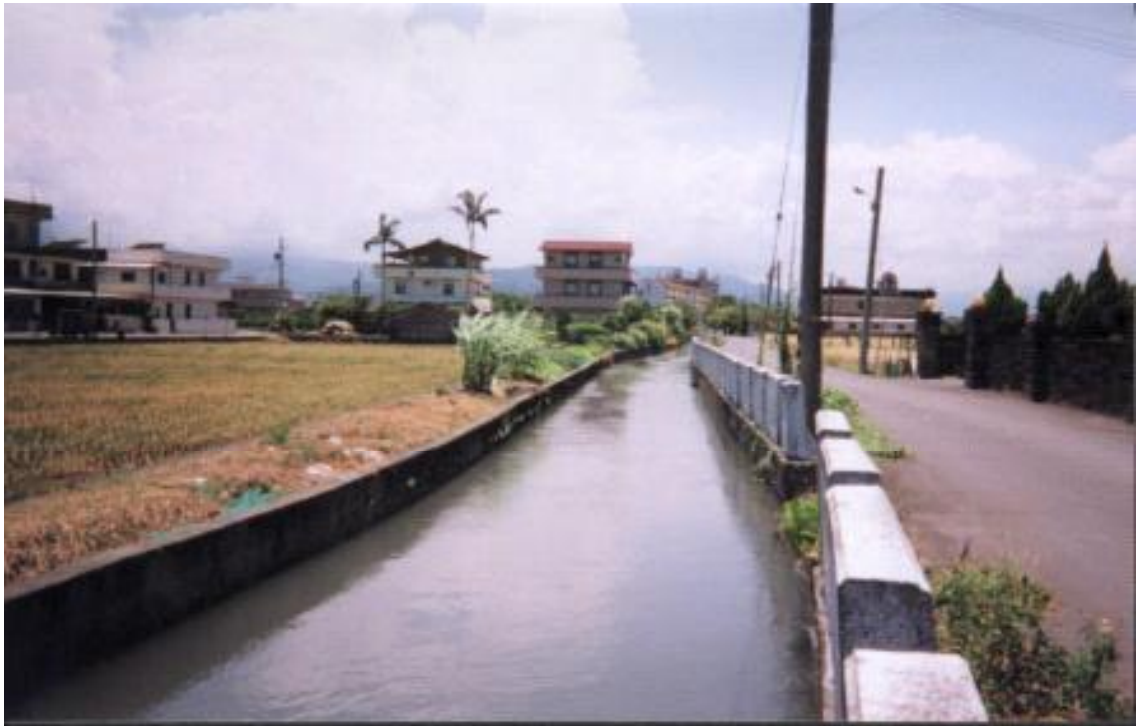
萬長春圳四結幹線（旁為復興街 261 巷）
