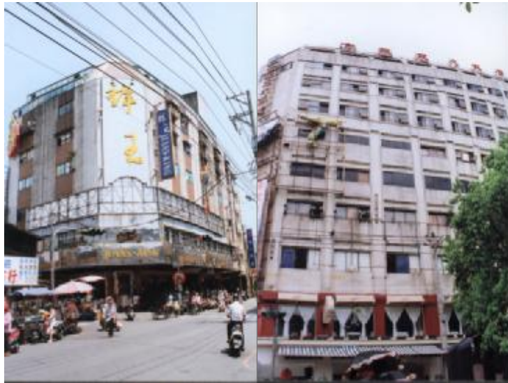
中正路與民生路口高興大樓
