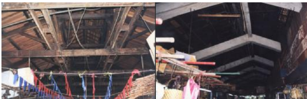
第一、二市場木造屋樑與水泥鋼樑結構槌屋頂（公元 1953 年（民 42 年）建）
