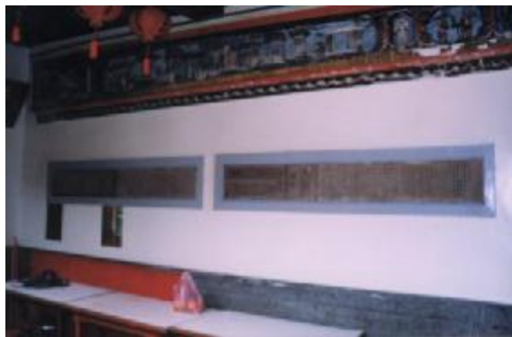
震安宮後殿右側全景（乙）
